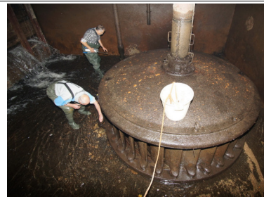
Wartungsarbeiten an der Turbine
