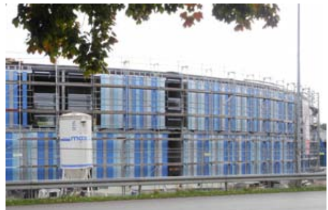
Die neue Eishalle im Ellental zeigt bereits die farbige Außenhülle
